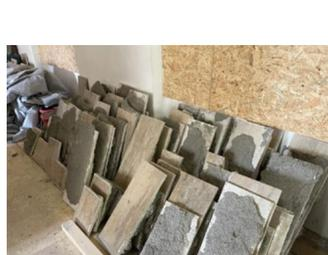
Auch alte Bodenbeläge wurden sorgfältig ausgebaut. Der Buchen-vollholzparkett aus dem alten Noviziat wird aufbereitet und wieder verlegt. Ebenso wurden alte Dielenböden ausgebaut und von unserer k\_m-Tischlerei aufbereitet. Die aufbereiteten Bodenbeläge werden in den ursprünglichen Räumen wieder verlegt. Weiters verwenden wir die historischen Zimmertüren weiter: Nach ihrer Aufbereitung werden sie als Badezimmertüren dienen.
